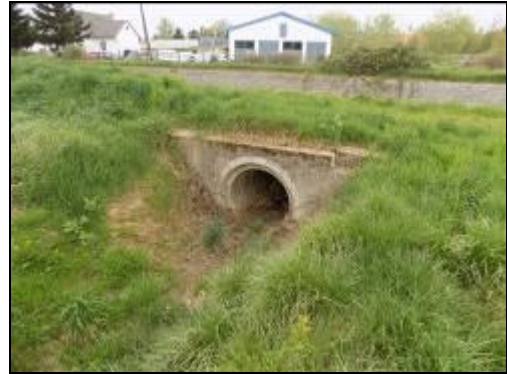
19+917 km szelvényben elzárás nélküli bevezetés
