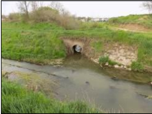
19+434 km szelvényben elzárás nélküli bevezetés
