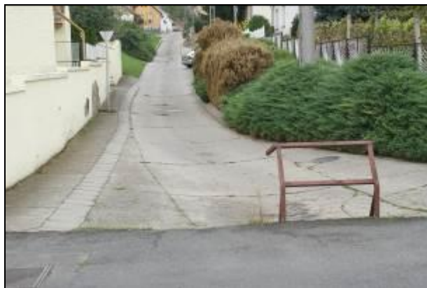
Attila utcai vízlevezetés a burkolaton
